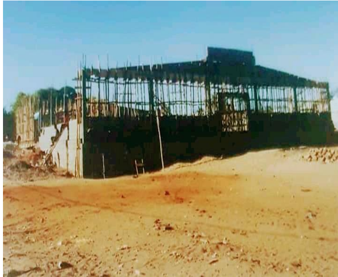
Photo 24 : Le marché en construction à Eberhard
